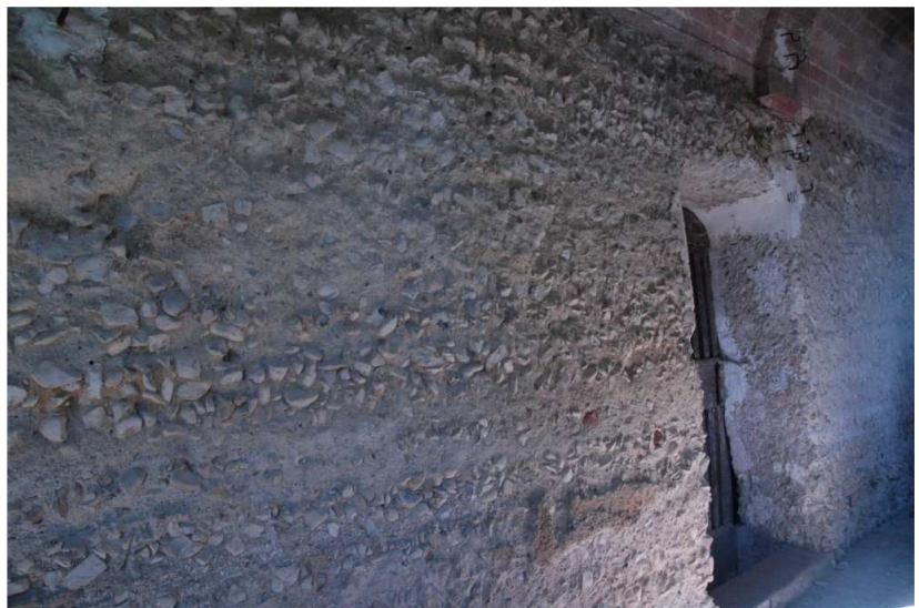
Ingresso ad una "cisterna romana" – veduta del fronte in opus caementicium . Ex -Residenza estiva Padri Filippini.
