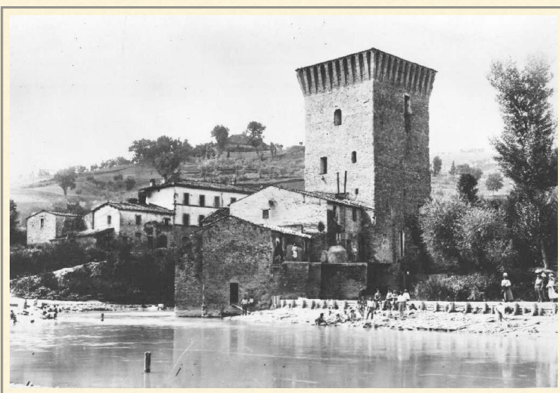
Fig. 2.I.I - Torre e molino di Pretola (primi del '900)
