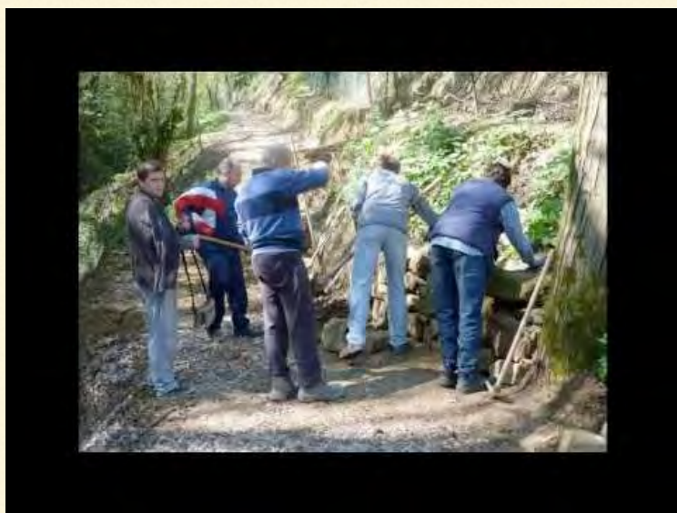
Filmato 9.1 - Lavori per il ripristino del sentiero
