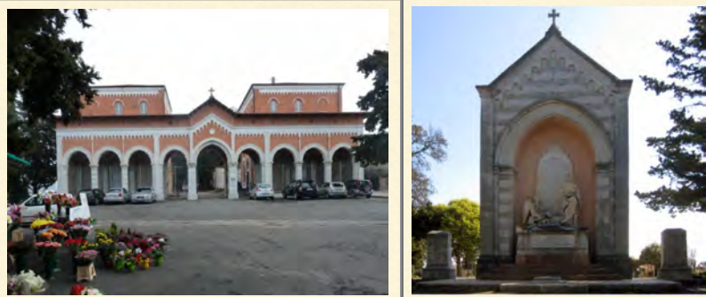
Figg. 5.10, 5.11 - Civico cimitero monumentale di Perugia
